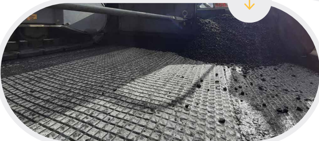
...mit Asphalt überbauen
