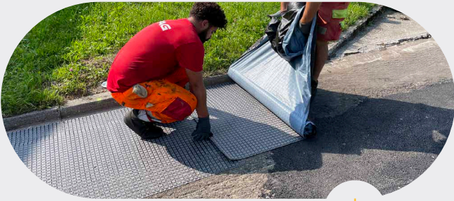
GlasGrid® Rapid ausrollen und die Folie gleichzeitig abziehen
